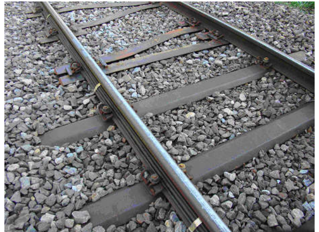
Übergangsgleis bei der Vorbildbahn, deutlich sichtbar an den Veränderungen der Schwellen
