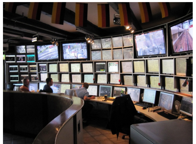
Rund 40 Rechner sind im Einsatz, um im „MiWuLa“ den Anlagenbetrieb zu organisieren und zu überwachen
