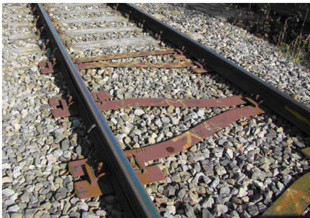
Übergangsschwelle von Holz- zu Stahlschwellen hin
